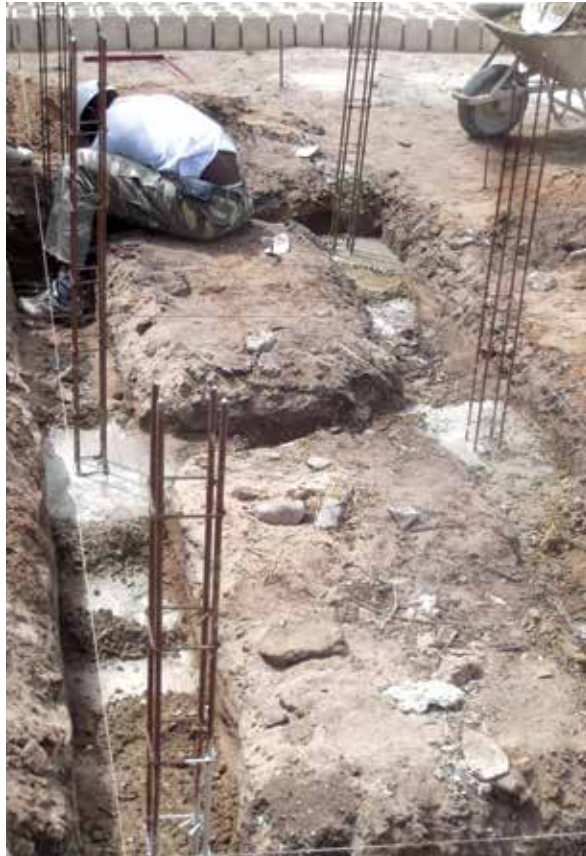
5 - Du fer est installé à l'intérieur de la tranchée, la fondation est ensuite coulée
