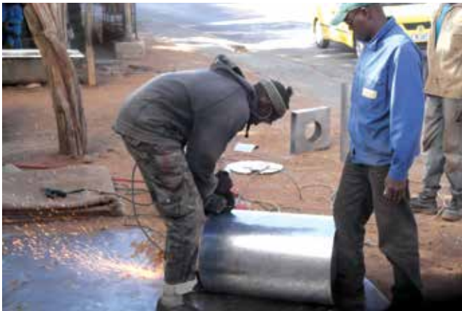
34 - Confection du fût avec une feuille métallique enroulé sous forme cylindrique
