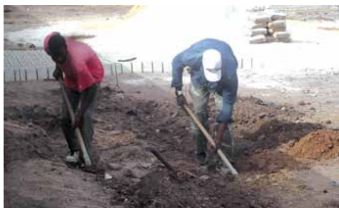
3 - Nivellement du sol - Fondation
