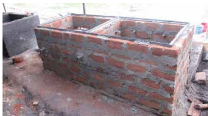
2 - Armature à double compartiment en briques
