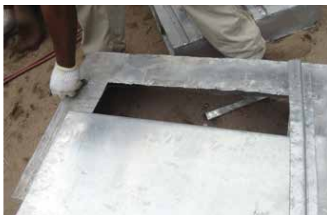
19 - Plaque à cendre insérée en bas du caisson
