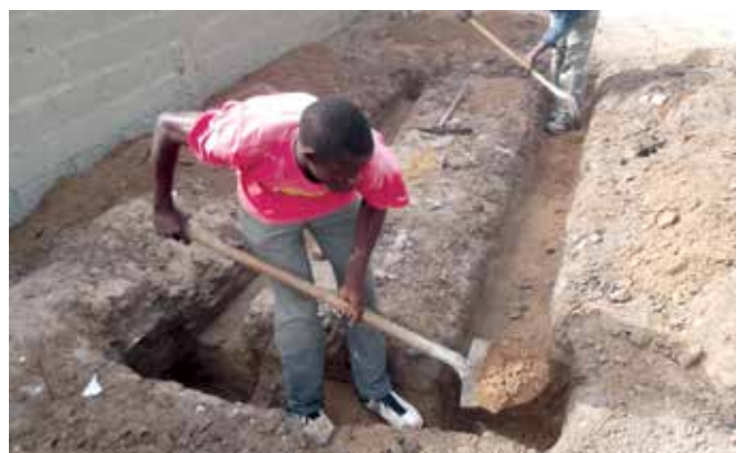
4 - Creusage d'une tranchée de 20 cm
