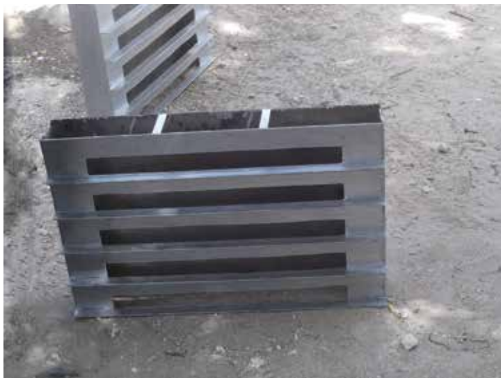
41 - Utilisation de feuille en acier galvanisé pour la confection des caissons de sortie d'air
