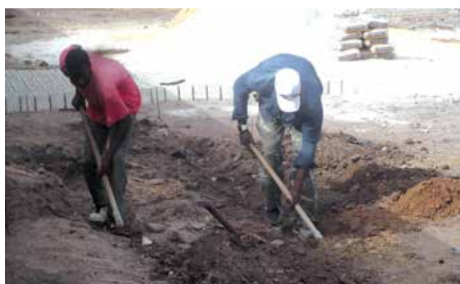
3 - Nivellement du sol - Fondation
