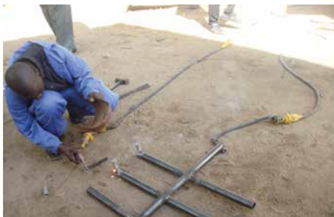
20 - Assemblage des tubes en fer qui servent de tuyaux d'air
