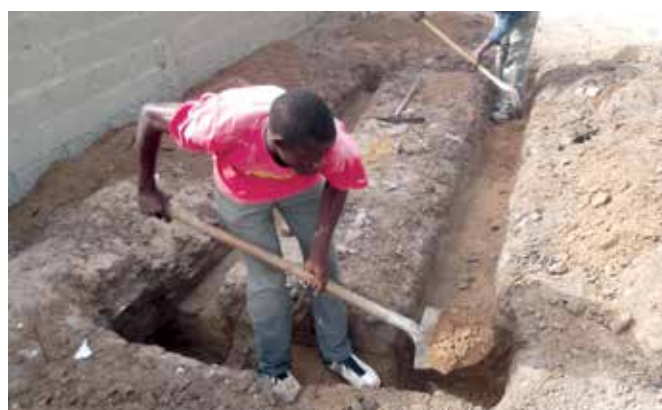
4 - Creusage d'une tranchée de 20 cm
