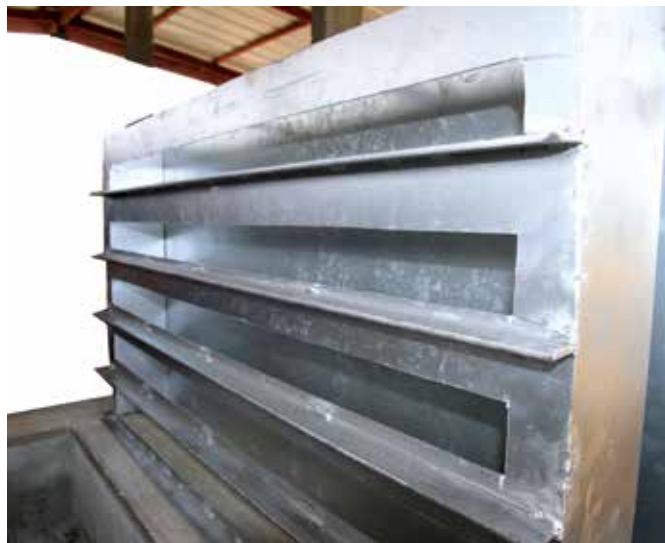
42 - Incisions/sorties d'air formant les ailettes
