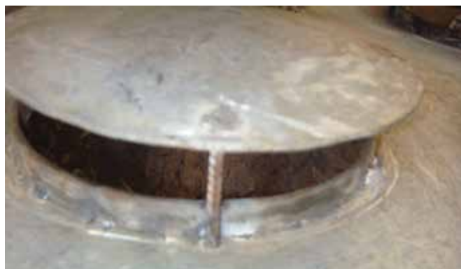
27 - Trou coiffé par un cône
